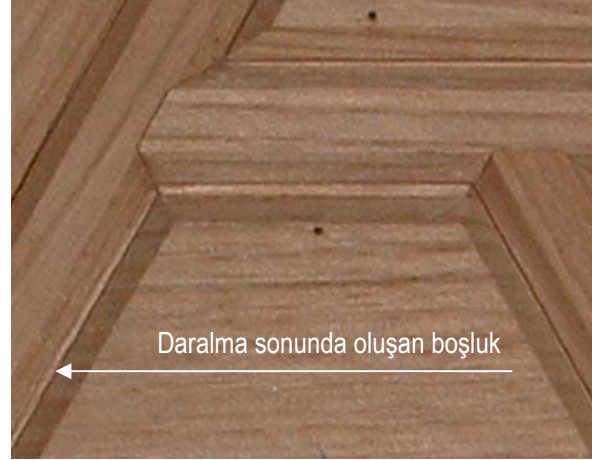
Şekil 5. Daralma sonucunda oluşan boşluk (The gap from the swelling occurrence)
