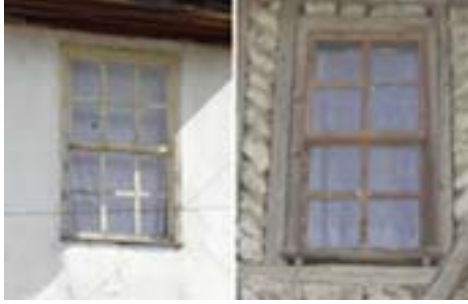
Şekil 9. Tespit edilen geleneksel pencere tipleri (Surveyed traditional window types)
