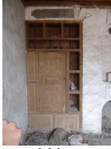
Şekil 12. Ocak yanı dolabı görünüşü (View of closet located next to fireplace)
