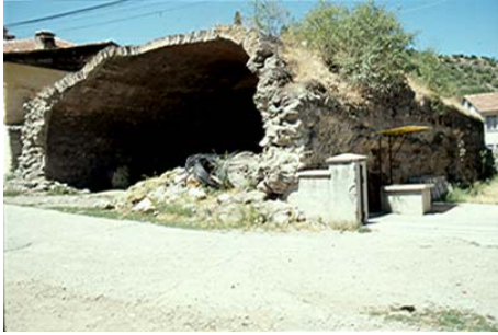
Şekil 17. Günümüzde var olmayan “Menzil Hanı”nın yıkılmadan önceki durumu (View of “Menzil Hanı” (the caravansaray) before it collapsed)
