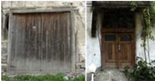
Şekil 10. Tespit edilen kapı tipleri (Surveyed traditional door types)
