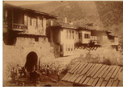
Şekil 15. "Büyük Kapı"nın 1900'lerin başındaki durumu (View of "Büyük Kapı" (The Great Door) in early 1900s)
