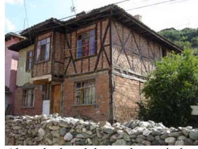
Şekil 8. Ahşap karkas dolgu malzemesi olarak çağdaş malzeme kullanımı (Use of contemporary building materials as core of a wooden frame structure)
