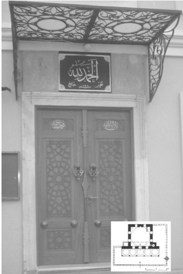
Resim 8: Caminin batı cephesi giriş kapısı
