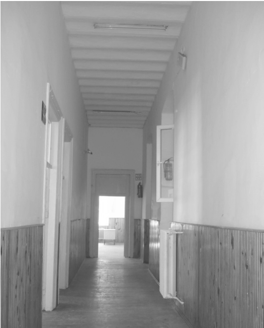
Resim 13: Koridor tavanında volta döşeme
