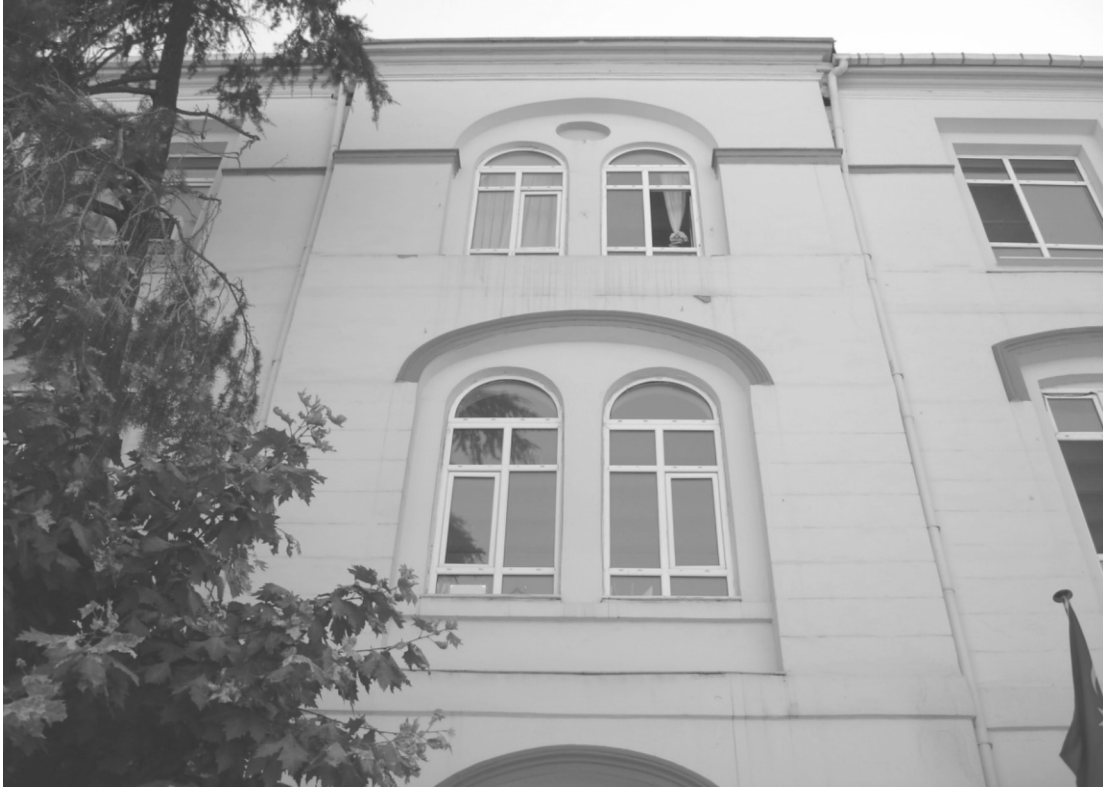
Resim 16: Giriş cephesinde dışa taşan bölüm
