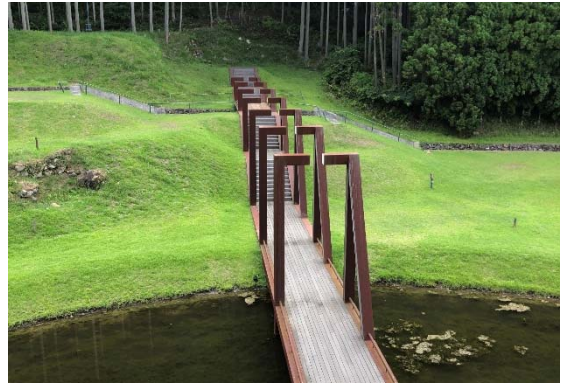
Şekil6. Güney çıkış kapısına giden köprü
