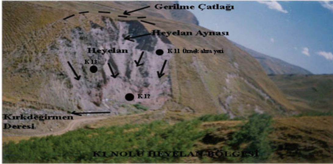
Şekil 9. Kırkdeğirmenler mahallesi K1 nolu yamacın görüntüsü (Image of K1 numbered slope in Kırkdeğirmenler neighbourhood)
