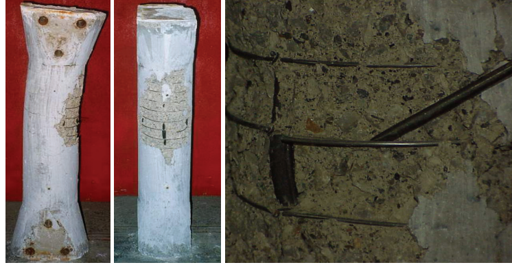
Şekil 5. SC10 Kolonunun Deney Sonrası Görüntüleri ve Fret Donatısındaki Kopma (Specimen SC10 after the Test and Rupture of Spiral Reinforcement)
