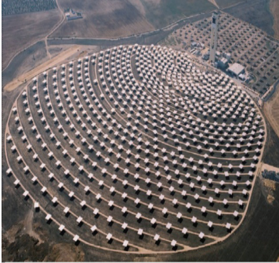
Şekil 1. PS10 tesisinden bir görüntü [1]. (PS10 plant)
