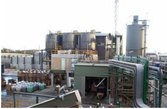
Şekil 3.34. Lidcombe sıvı atık tesisi [42]
