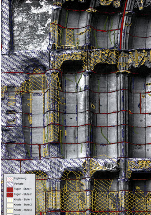
Şekil 5. Düzeltim ve çözümleyici bilgi işleme işlerini birleşik olarak yapabilen bir yazılım (Metigomap) ile gerçekleştirilen değerlendirmeler sonucu elde edilen bir bozulma gösterimi [9]
