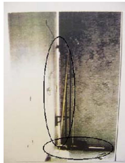
Şekil 1. Panellerin yerlerine yerleştirilmeleri ve derz aralığında oluşan sapmalar (Bilkent konutlarından) [4]
