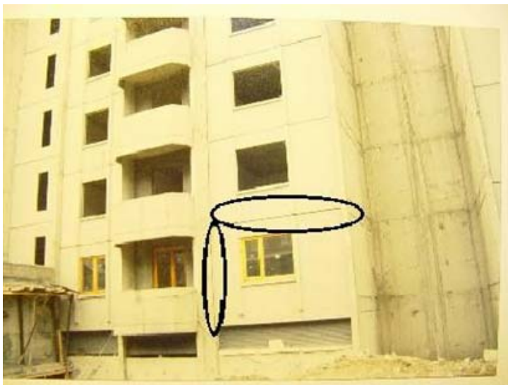
Şekil 1. Panellerin yerlerine yerleştirilmeleri ve derz aralığında oluşan sapmalar (Bilkent konutlarından) [4]
