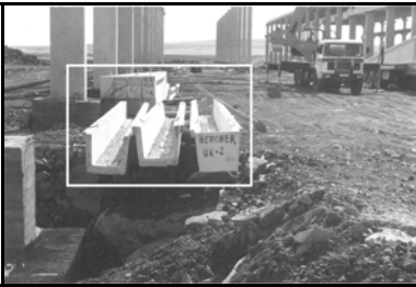
a- Şantiyede oluk kirişlerinin depolanması
