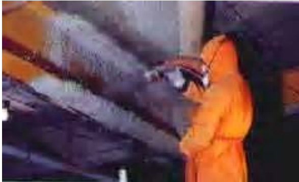
Şekil 11. Püskürtme sistemlerin çelik kirişe uygulanması
