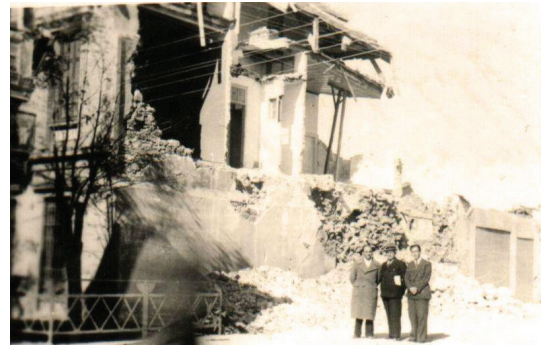
Resim 1. 1944 depreminin Ayvalık'taki bir binaya yapığı hasar (Ceynur Karagözoğlu arşivinden).
