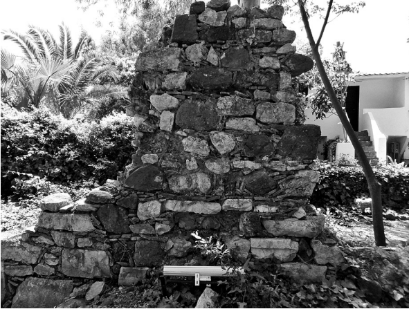
Res. 6 Güney nef üzerindeki cephe duvarı
