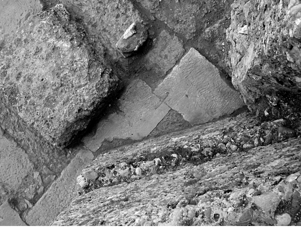
Fig. 8 Güney Cephe; Evre I: Güney giriş merdiveni. Evre II: Tapınağın güneydoğu köşesinin tiyatronun ayakları ve gergi duvarı ile kesilmesi.
