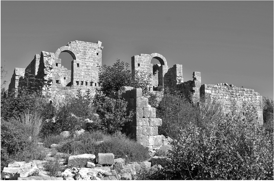
Fig. 4 Ansicht von Nordwesten
