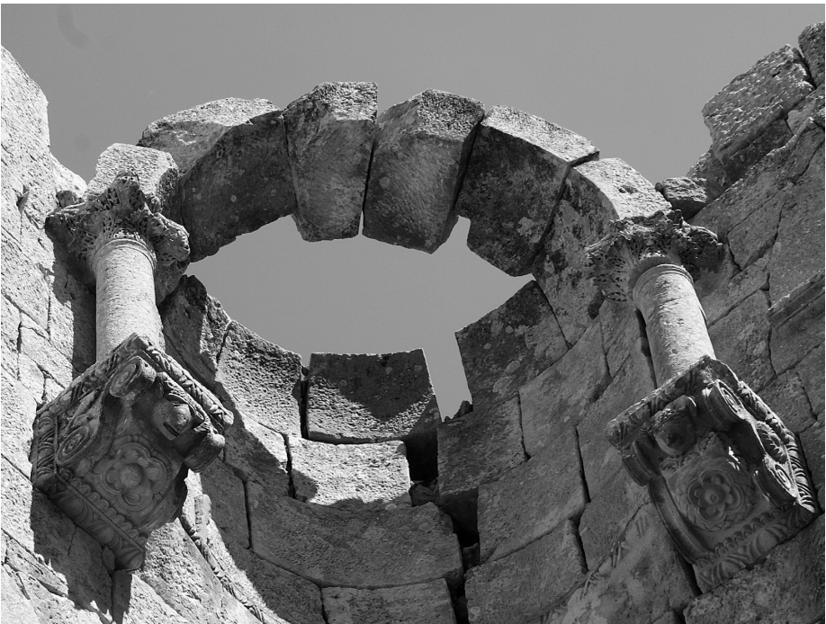
Fig. 8 Alahan Manastrir, Ostkirche, Balkenaufleger im Zwickel zwischen der Nische der Nordostecke und der Ostwand des Turmes.
