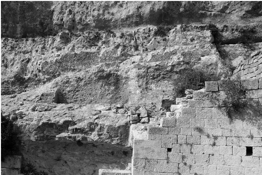
Fig. 4 Alahan Manastir, Westkirche, nördlicher Apsisnebenraum, Emporengeschoss mit Treppierungen zur Aufnahme von Mauerwerk.
