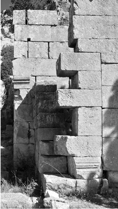
Fig. 5 Alahan Manastir, Baptisterium, Süd- und Westwand des Vorraums, die unterschiedlichen Schichthöhen sind deutlich zu erkennen.
