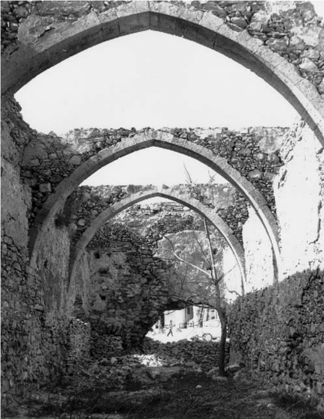
Fig. 9 Kelenderis Liman Hamamı, III. Mekan'da sonradan yapılan üst örtü
