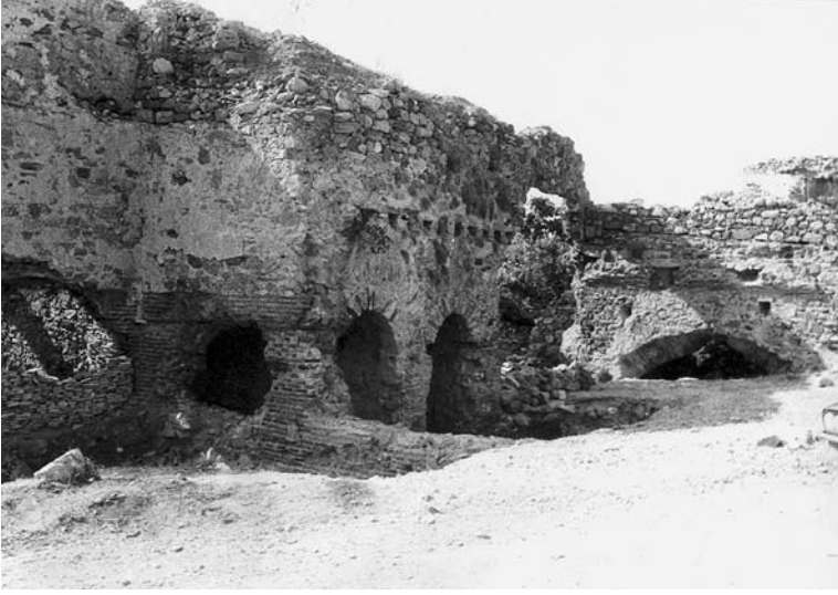
Fig. 10 Kelenderis Liman Hamamı, VII. Mekan tonozlu odacıklar ve praefurnium'un kuzeyden görünüşü
