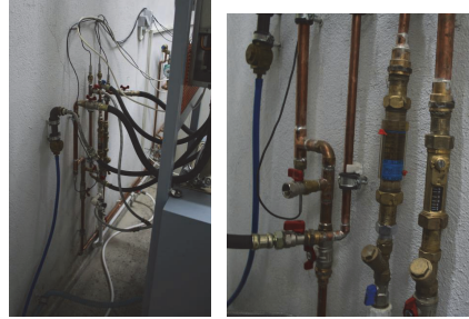
Şekil 8. Tesisat bağlantı noktasının genel görünümü ve iki adet debimetrenin (rotametre) yakından görünümü (General view of the installment and closer view of the two rotameters)
