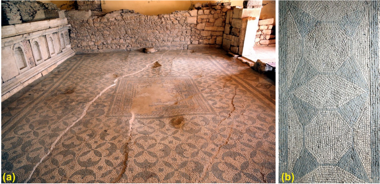
Şekil 14. a) Neon kütüphanesi tabanında kullanılan beyaz – bej ve gri renkli kireçtaşlarından yapılmış mozaik döşeme, mozaik döşemelerde Sagalassos fayındaki tarihsel depremler sonucu oluşan çökmeler. b) Mozaik döşeme yakın plan görünümü.
