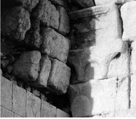
Fig. 7 Korykos Taki'na ait plaster Korinth başlığı
