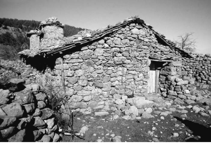
Fig. 4 Kabaoluk Trkmen Damı
