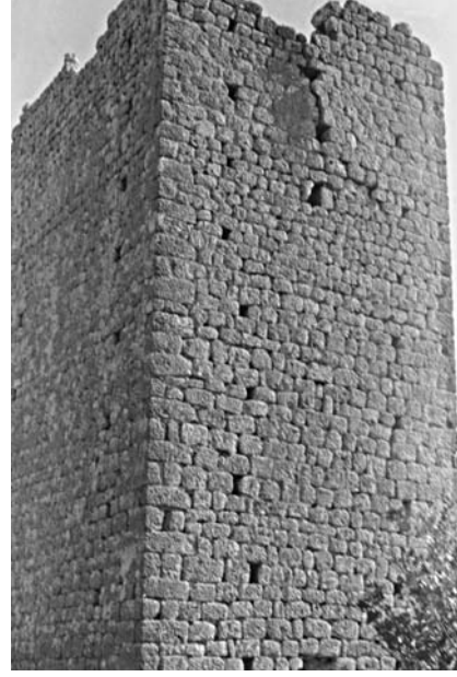
Fig. 7 Olba bölgesinde bulunan Bizans dönemine ait kule örneği, Gökburç
