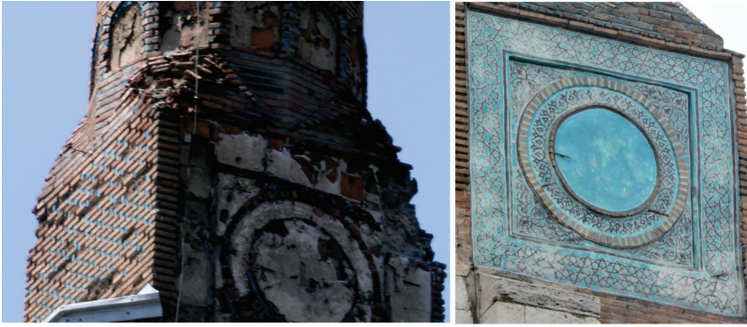
1- Yapının 2004 tarihindeki fotoğrafı
