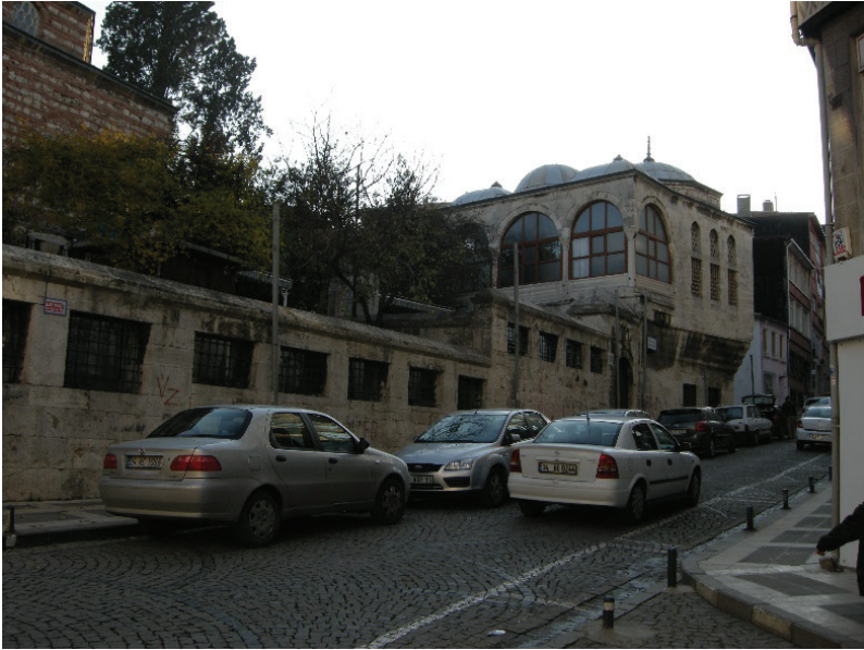
G.17. Ahmediye Külliyesi Kütüphanesinden Bir Görünüm (Seda COŞKUN, 2011)
