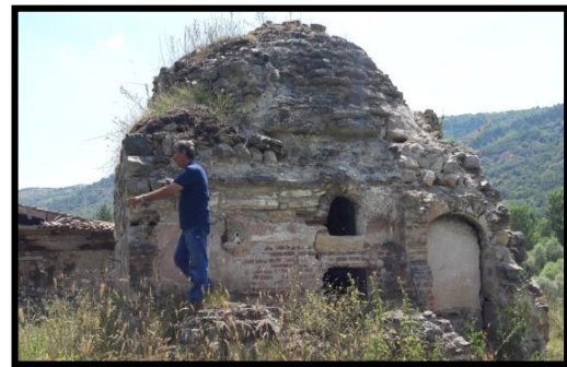
Şekil 4: Hamamlı Köyü'ndeki Erken Osmanlı Hamamı'ndan bir görünüm (Orijinal)
