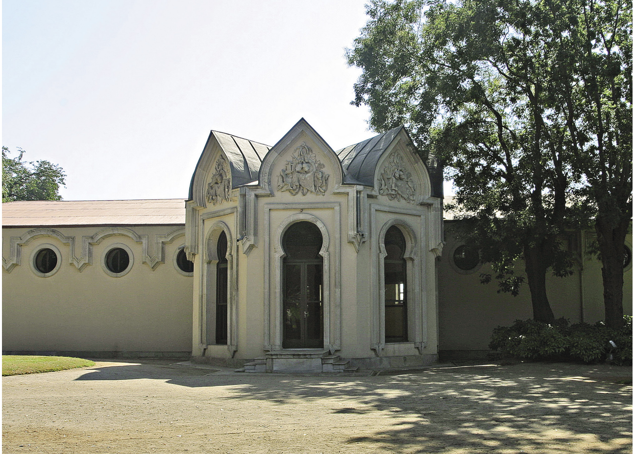
26 Ahır Köşkü dış cephe görünümü
