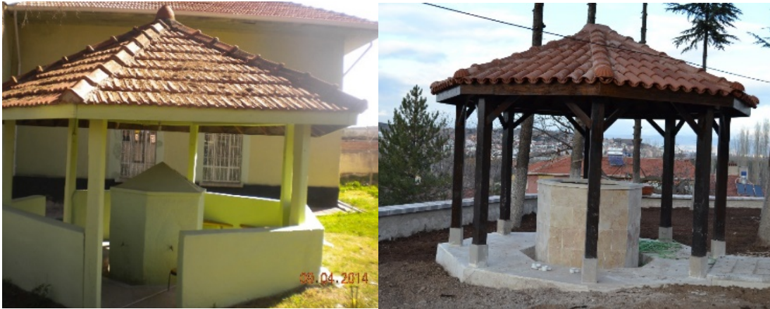
Fotoğraf 5- Karacaşehir Camisi şadırvanı restorasyon öncesi ve sonrası
