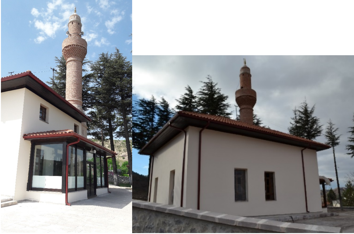
Fotoğraf 3- Karacaşehir Camisi restorasyon öncesi giriş, yan ve arka cepheler
