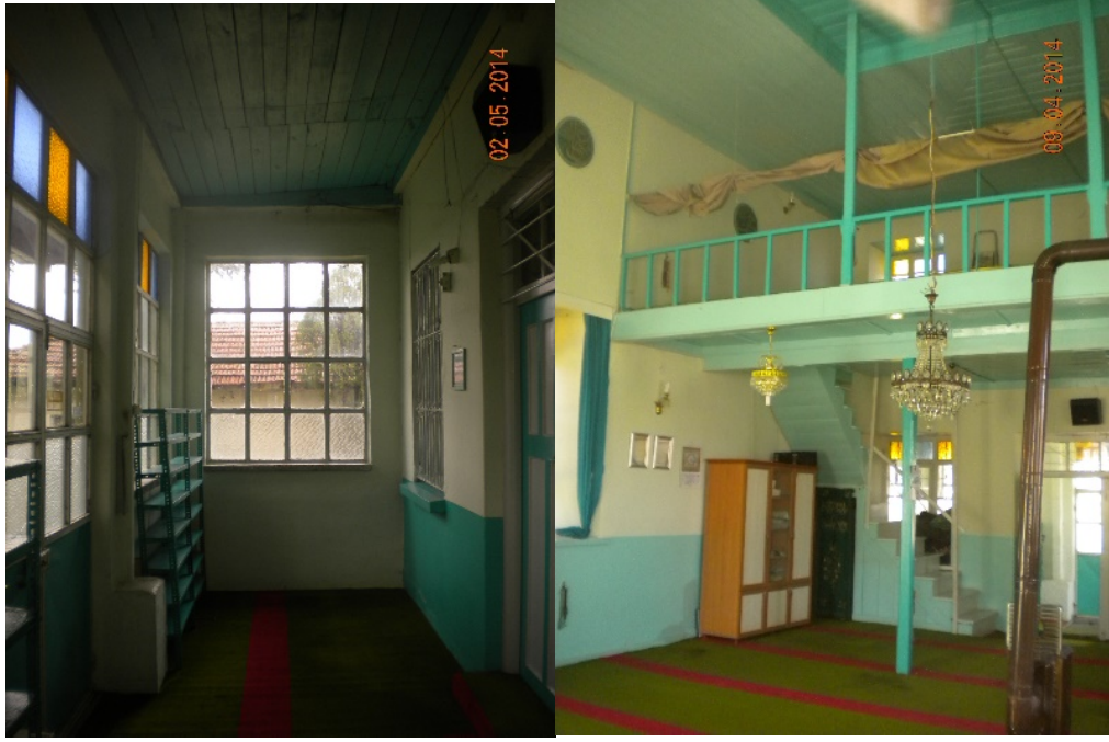
Fotoğraf 6- Karacaşehir Camisi restorasyon öncesi son cemaat yeri ve kadınlar Mahfili
