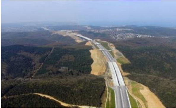
Şekil 3. Üçüncü Köprü ve Kuzey Ormanlarında tahribat (Kaynak: Akkemik, 2020).
