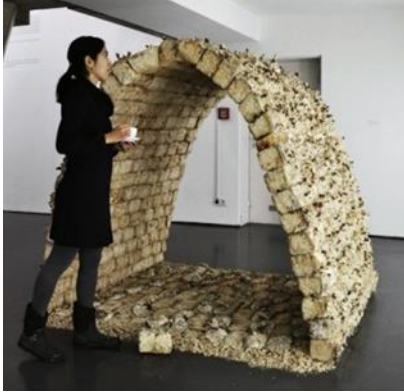
Şekil 6. Reishi mantarlarından yapılmış Mycotecture Alpha (Mycotecture Alpha, 2009)
