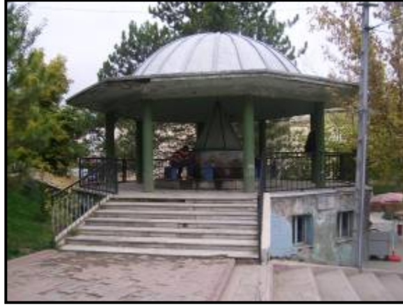
Şekil 11. Uygulama öncesi Buruciye Medresesi önünde bulunan şadırvan ve tuvalet
