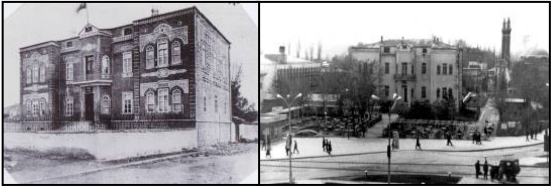
Şekil 4. Yapının vali konağı olarak yapıldığı ilk hali ve Halkevi'ne dönüştürülmüş hali
