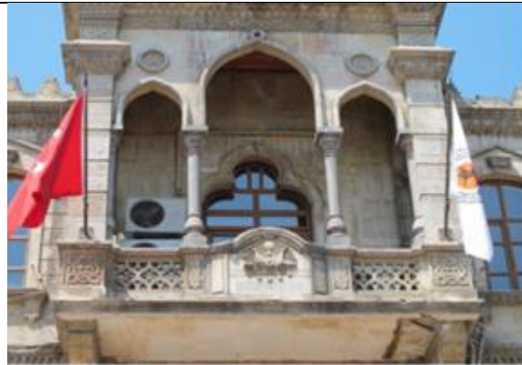
Resim 4. Eski Belediye Sarayı Binası 2. Kat Balkon
