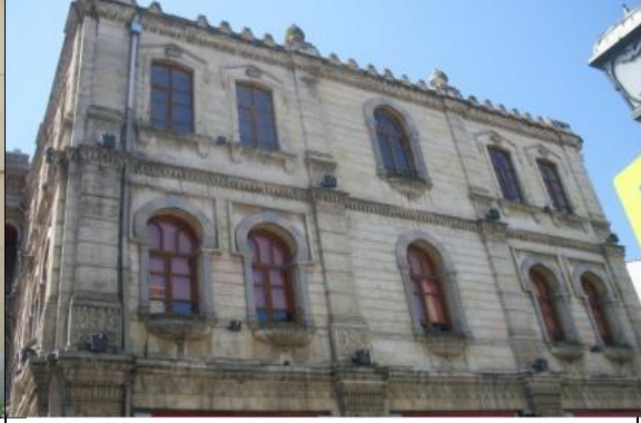
Resim 15. Eski Belediye Sarayı Binası Kuzey Cephe
