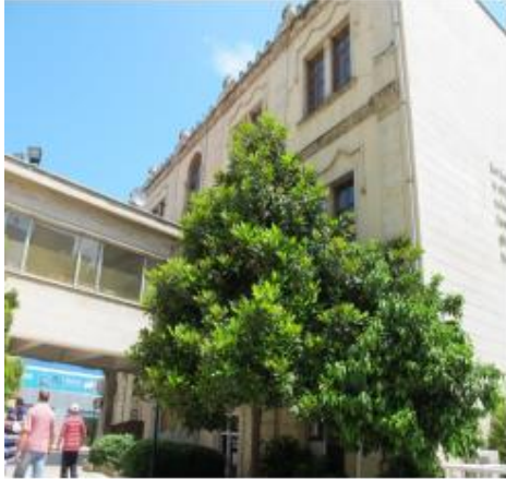
Resim 10. Eski Belediye Sarayı Binası Batı Cephe
