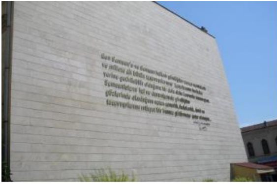
Resim 18. Eski Belediye Sarayı Binası Güney Cephe
