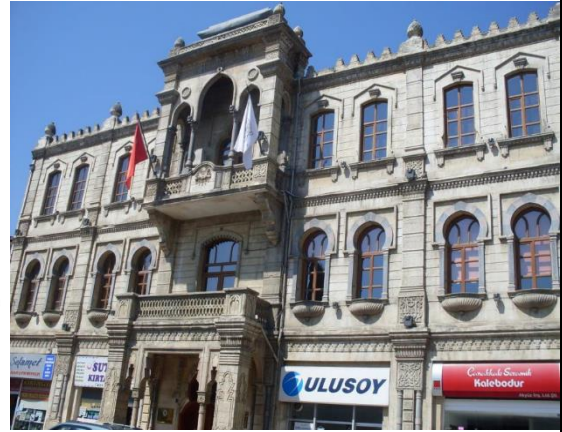
Resim 1. Eski Belediye Sarayı Binası Doğu Cepheden
