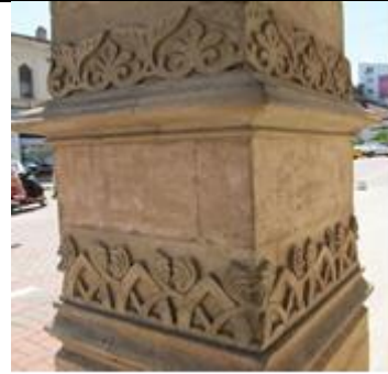
Resim 9. Giriş Cephesindeki Sütun Süslemelerinden Ayrıntı
