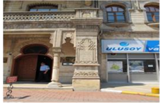
Resim 7. Eski Belediye Sarayı Binası Giriş Cephesi
