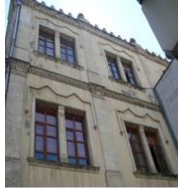
Resim 11. Eski Belediye Sarayı Binası Batı Cephe
