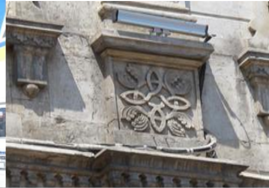
Resim 17. Eski Belediye Sarayı Kuzey Cephe Giriş Katı
