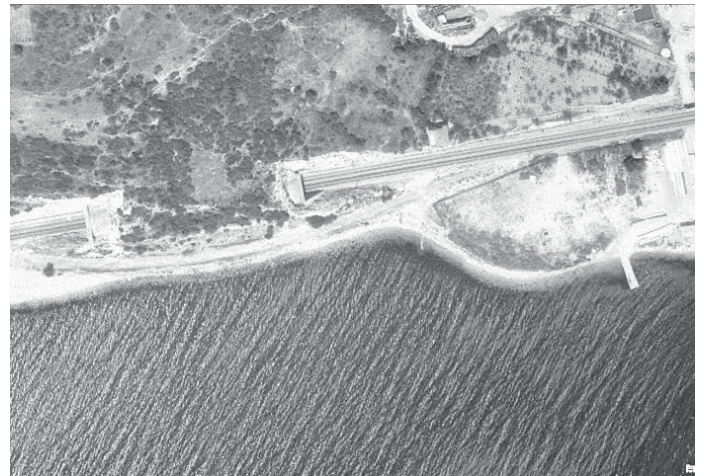
Foto 13: 1976 yılı hava fotosunda "Ada Tepe tüneli" ve yapay kıyının oluşumu. Kıyı ile tünel arasındaki iz; eski tren yolu platformudur.
