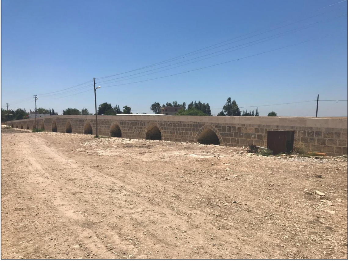
Fotoğraf 8. Kırıkhan-Reyhanlı Yolu Üzerinde Bulunan Muratpaşa Köprüsü'nden Bir Görünüm.
