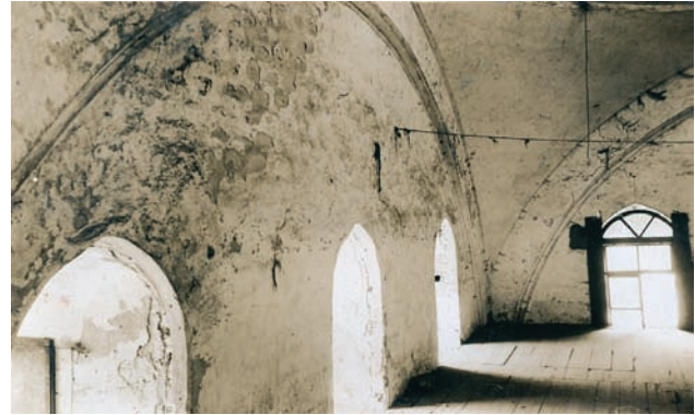
Resim 6. Hamamın içine sonradan eklenen ara katların görünüşü, 1937 (KTVKK arşivi, dosya no:1180)
