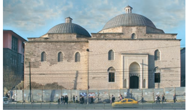
Resim 20. Hamamın onarım sonrası görünüşü
