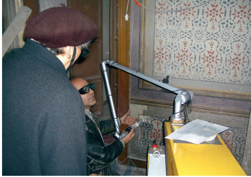
Resim 8. Pertevniyal Camii duvar süslemelerinin temizlik denemesi
