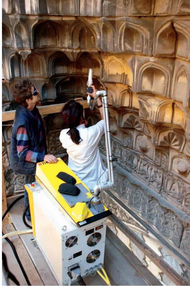
Resim 4. Sivas Gök Medrese, Portal'in temizliği sırasında lazerin iskelede kullanımı
