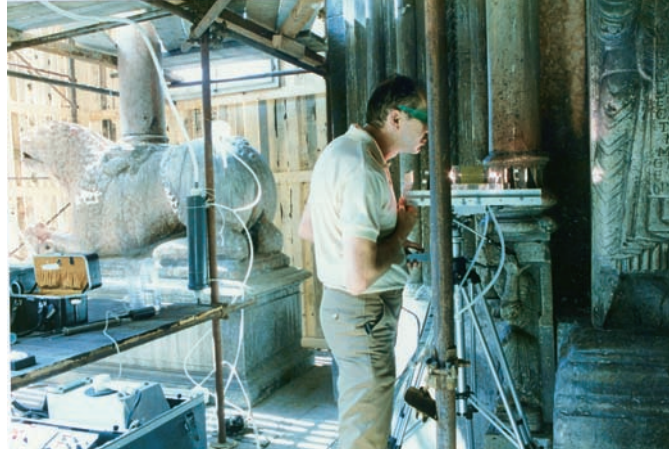
Resim 3. Dış cephede lazer ile yapılan bir uygulama (John Asmus, "Duomo di Cremona")
