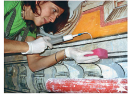
Resim 21. Sıva- duvar arasında oluşan boşlukların enjeksiyon harcı ile doldurulması
