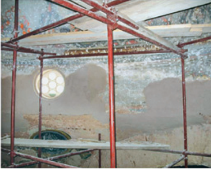
Resim24,25. Orijinal sıvaların arasındaki tuğla yüzeylerin sıvanması
