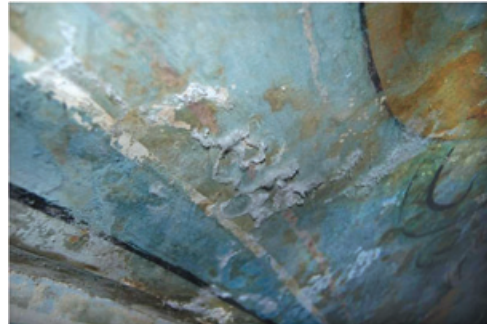
Resim 6. Tuzların boya yüzeyine çıkarak birikmesi
