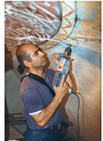
Resim 22,23. Duvar resimlerinin sağlamlaştırılması için kullanılan paslanmaz çelik saplamalar
