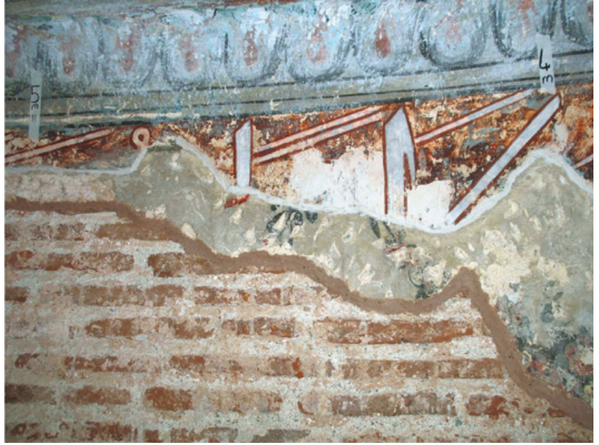
Resim 9. Raspa sonucu ortaya çıkan 18. ve 19.yy'a ait katmanlar
