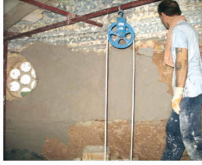
Resim24,25. Orijinal sıvaların arasındaki tuğla yüzeylerin sıvanması
