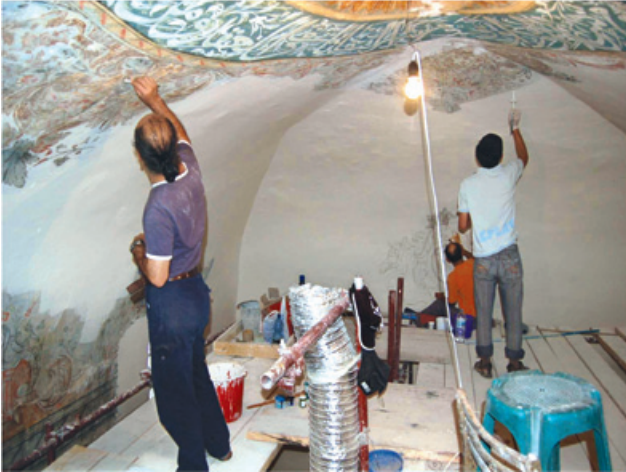
Resim 30,31. Orijinal duvar resimlerinin arasındaki eksiklerin rötuşlanması
