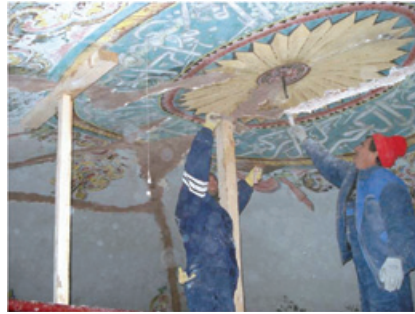
Resim 20. Ön sağlamlaştırma için duvar resimlerindeki çatlakların sıvanması
