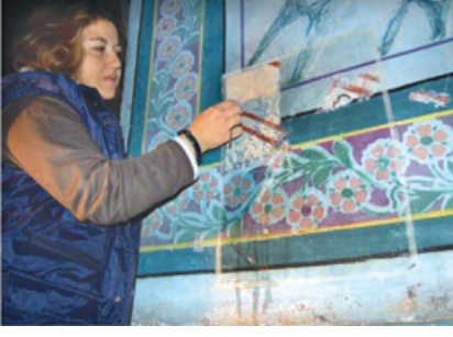
Resim 7. Boya katmanlarının açılması
