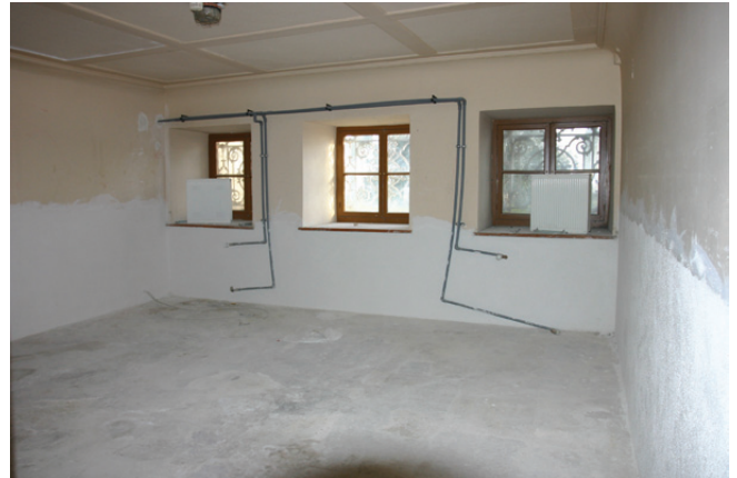
Resim 23. Duvarlarda ve zeminde yalıtım yapıldıktan sonra duvarların yeniden sıvanması
