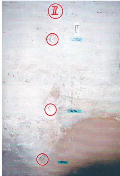
Resim 14. 74 no.lu oda (iç duvar)
