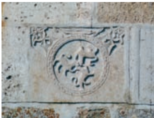
Resim 21. Kemer duvarının üzerinde yer alan üçlü aslan kompozisyonu
