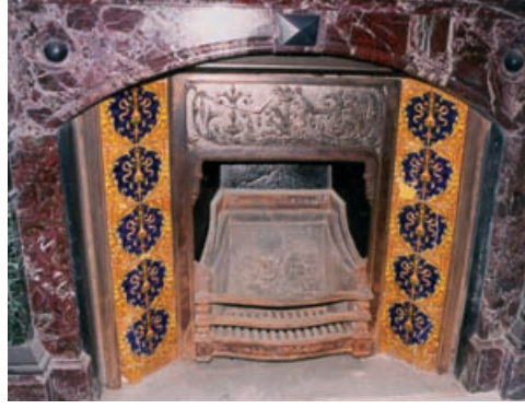
Resim-20 ve 21: Si-nevizyon Odasındaki Şömine (Şömine-4) Restorasyon Öncesi ve Sonrası
