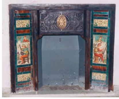
Resim-1: Toplantı Odası'ndaki Şömine (Restorasyon Öncesi)
