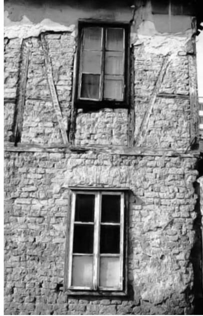
Avrupa, Balkanlar, Türkiye gibi geniş bir coğrafyada görülen, kerpiç dolgulu ahşap karkas yapım tekniği (Feilden, 2003, s.74)
