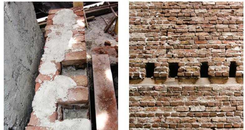
Resim 11. İleride kirişlerin hatla bağlanması için örgüde bırakılan boşluklar
