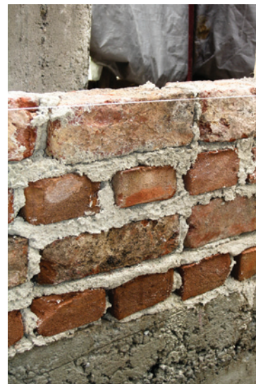
Resim 7. Özgünleri ile aynı boyuttaki yeni tuğlalar
