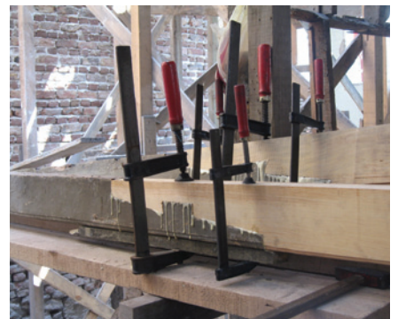
Resim 37. Bütünleme tekniğinin kirişlerde uygulanması
