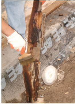
Resim 21. "Fırça ile sürme" tekniğiyle emprenye
