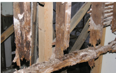
Resim 16. Taşıyıcı işlevini yitirmiş olan elemanlar
