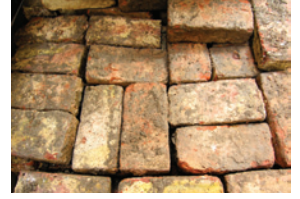
Resim 4. Sağlam olarak çıkarılarak kenara ayrılan harman tuğlaları
