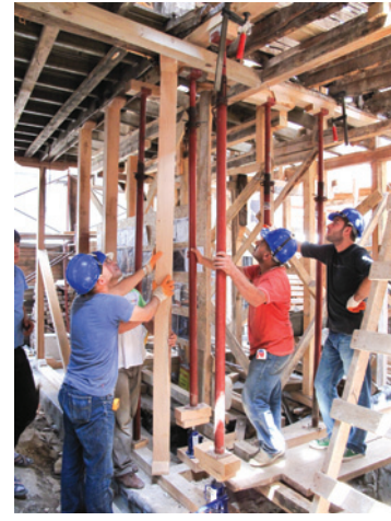
Resim 15. Taşıyıcı sistemin krikolar yardımıyla kaldırılarak teraziye alınması
