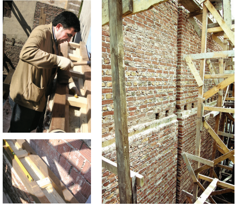
Resim 9. Duvarın içerisine kat seviyelerinde meshe hatılların yerleştirilmesi
