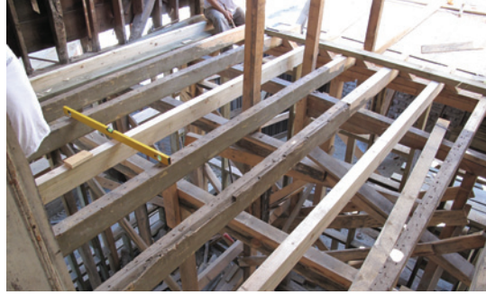
Resim 38. 1K02 mekânı döşeme onarım süreci
