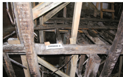
Resim 17. Cins tayini için ahşap elemanlardan örnek alımı
