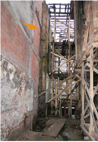
Resim 1. Yangın duvarının uygulama öncesi durumu
