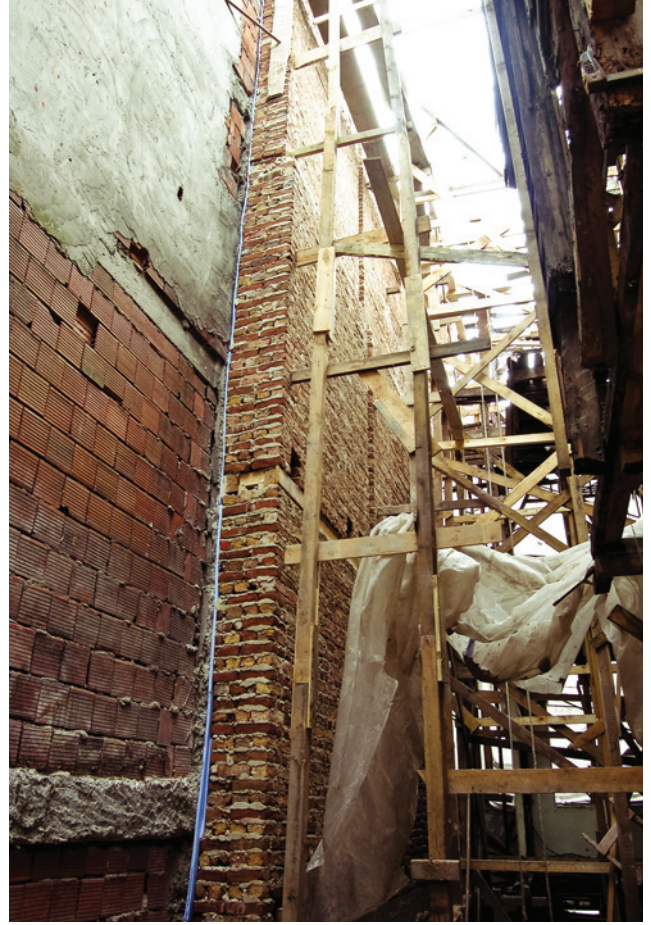
Resim 13. Yangın duvarının uygulama sonrası durumu
