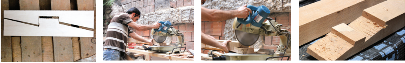
Resim 18. Kurt ağı birleşim detayının uygulanması
