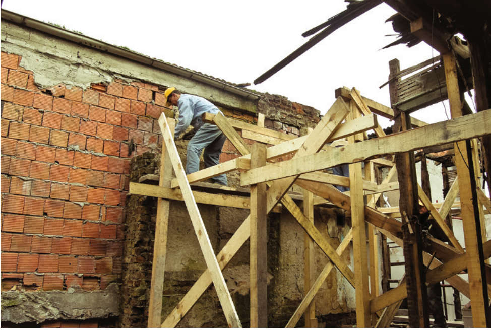
Resim 3. Yangın duvarının sökülmesi
