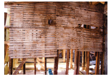
Resim 27. İç duvarlarda yapılan kısmi açmalar
