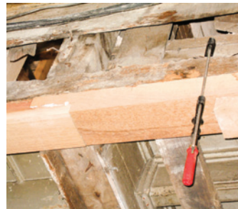
Resim 30. Yeni meşe yastığın eklenmesi
