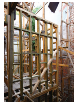
Resim 30. Yeni meşe yastığın eklenmesi
