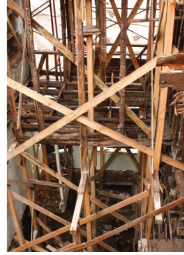
Resim 14. Ahşap yapıyı içeriden destekleyen askı iskelesi
