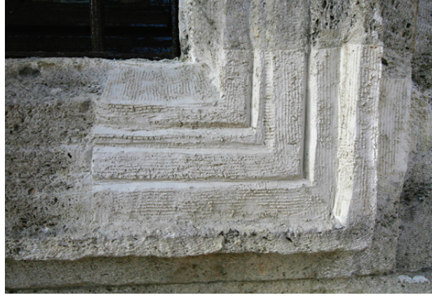
Şekil 18. Uygun olmayan bütünleme ve imitasyon uygulamaların- dan örnekler (KUDEB Rest. ve Kons. Lab., 2008- 2010)
