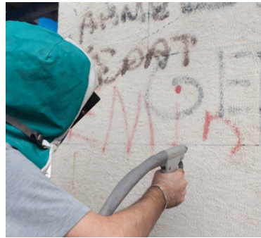
Şekil 16. Kontrollü mikro kumlama ile yüzey temizliği (KUDEB Rest. ve Kons. Lab., 2011)
