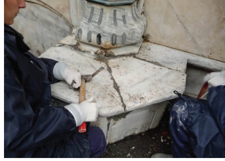
Mekanik yöntemlerle alınan niteliksiz dolgular
