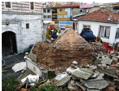
Kubbelerin üzerinde bulunan çimentolu bölümün raspa ile alınması
