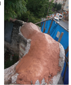
Üst örtüde yapılan Horasan sıva
