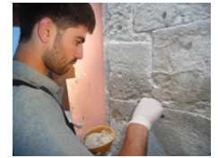
Yapılan dolgu çalışmaları
