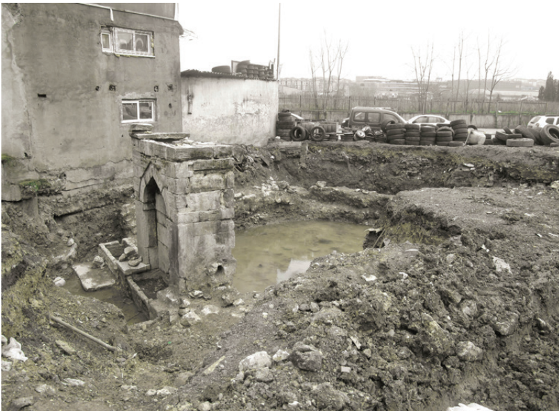
Yapılan kazıyla açığa çıkartılan özgün namazgâh duvarları
