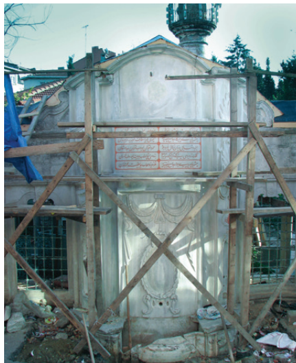
Kurna bölümünde yapılan kot çalışması
