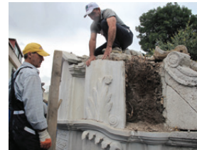
Cephe elemanlarını hareket ettiren odunsu bitkilerin uzaklaştırılması
