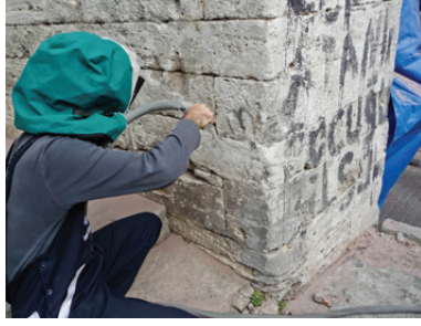
Kumlama yöntemi ile cephe temizliği
