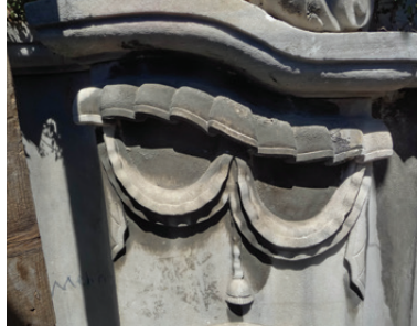
Cephede oluşan kabuklanmalar
