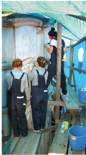
Cephede yapılan temizlik uygulaması
