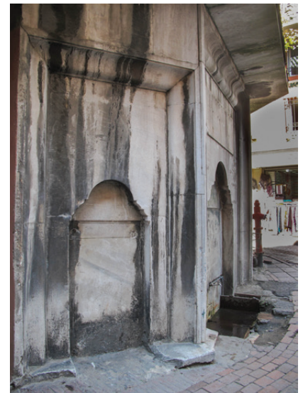
Yan cephe Restorasyon Öncesi
