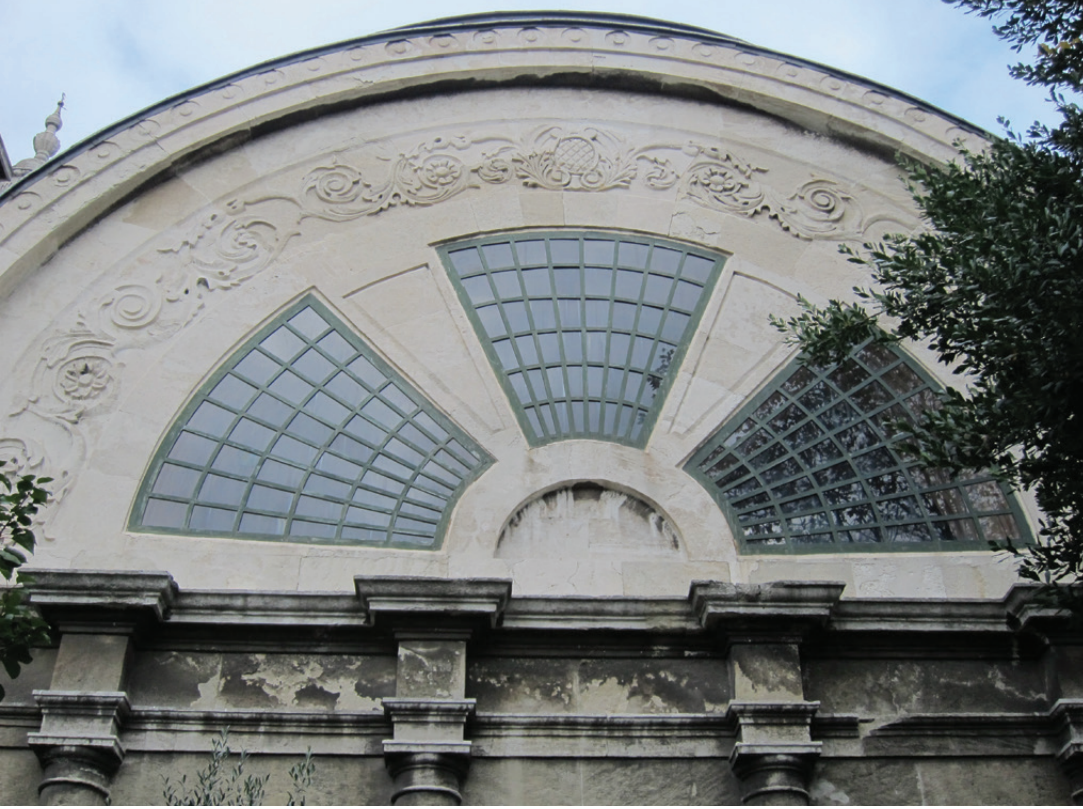
Resim 6. Cihangir Camii Üstyapı Camları
