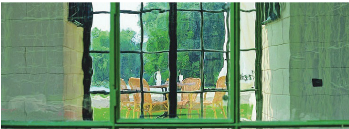
Resim 8. Restorasyon camı ile restore edilmiş Orangerie Sarayı, Schwerin, Almanya'dan bir detay fotoğrafı. 10
