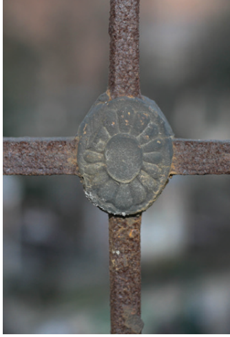
Şekil 16. Metal 1 Yapının pencere parmaklıklarında görülen lokma detayı
