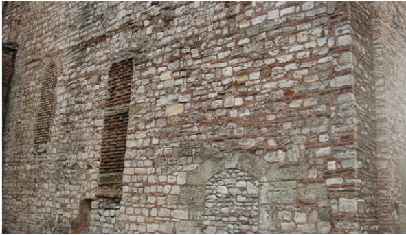
Şekil 9. Dış beden duvarında kullanılan yapı malzemelerinin genel görünümü (Fotoğraf: S. Angi).
