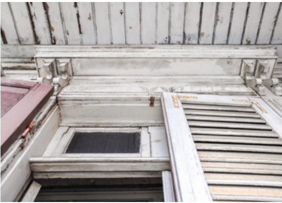
f. Köşkün giyotin pencerelerinde bulunan ahşap panjurlar yenileme sırasında kaldırılmıştır.
