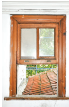
j. Köşkün pencere doğramalarındaki yenilemenin bina içerisinden görünüşü.
