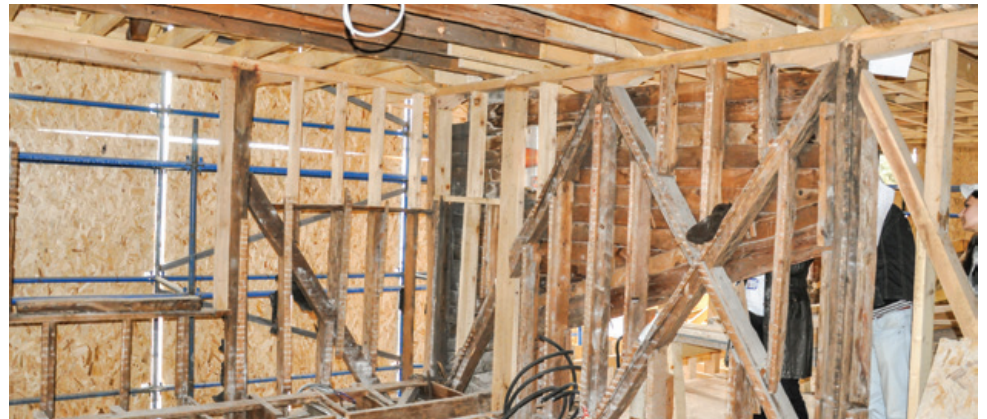
i. Taşıyıcı ahşap elemanlarda yenileme çalışmaları
