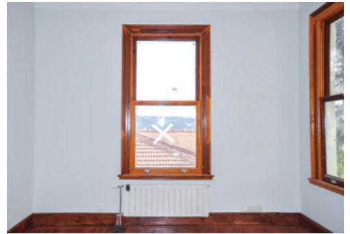
j. Köşkün pencere doğramalarındaki yenilemenin bina içerisinden görünüşü.
