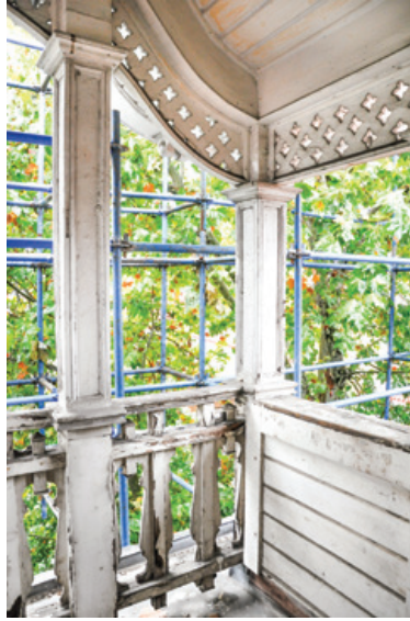
e. Restorasyon öncesi ve sonrasında balkon korkulukları ve balkon dikmesine ait görünüşler
