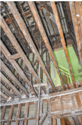
i. Taşıyıcı ahşap elemanlarda yenileme çalışmaları
