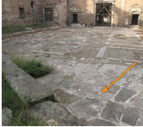
Şekil 19. Sekinin döndürülmesinden sonra yapılan döşeme
