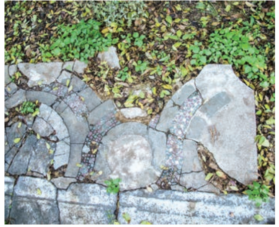
Şekil 66. Nartekste görülen döşeme kalıntısı
