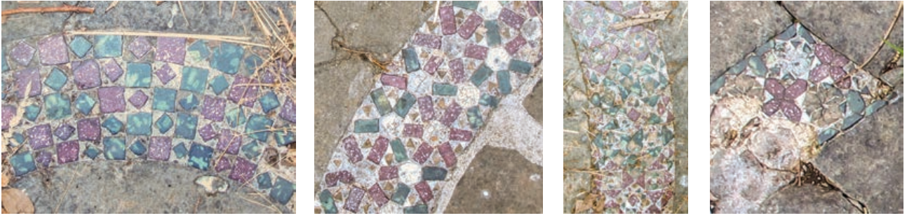
Şekil 10. Studios Bazilikası narteksinde kısmen korunmuş opus sectile döşemeden ayrıntılar
